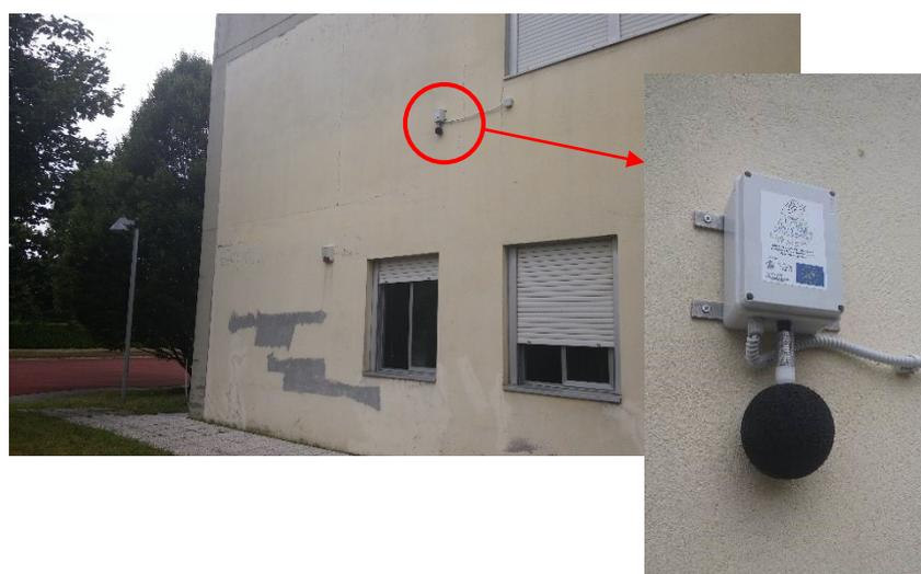
Figura 3. Esempio di sensore installato sulla facciata di un edificio pubblico.
